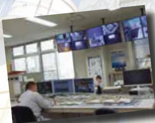
▲焼却場の操作室
