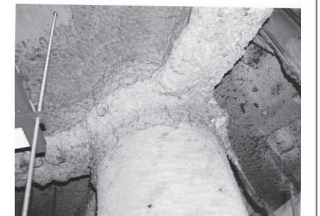
▲吹付け材が使われている建築物（出典：国土交通省資料「目で見えるアスベスト建材レベル1」）
