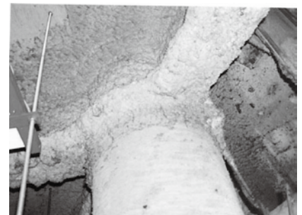
▲吹付け材が使われている建築物(出典:国土交通省資料「目で見えるアスベスト建材レベル1」)
