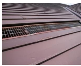
屋根塗装改修
