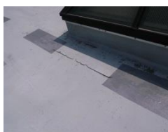
屋上防水改修
