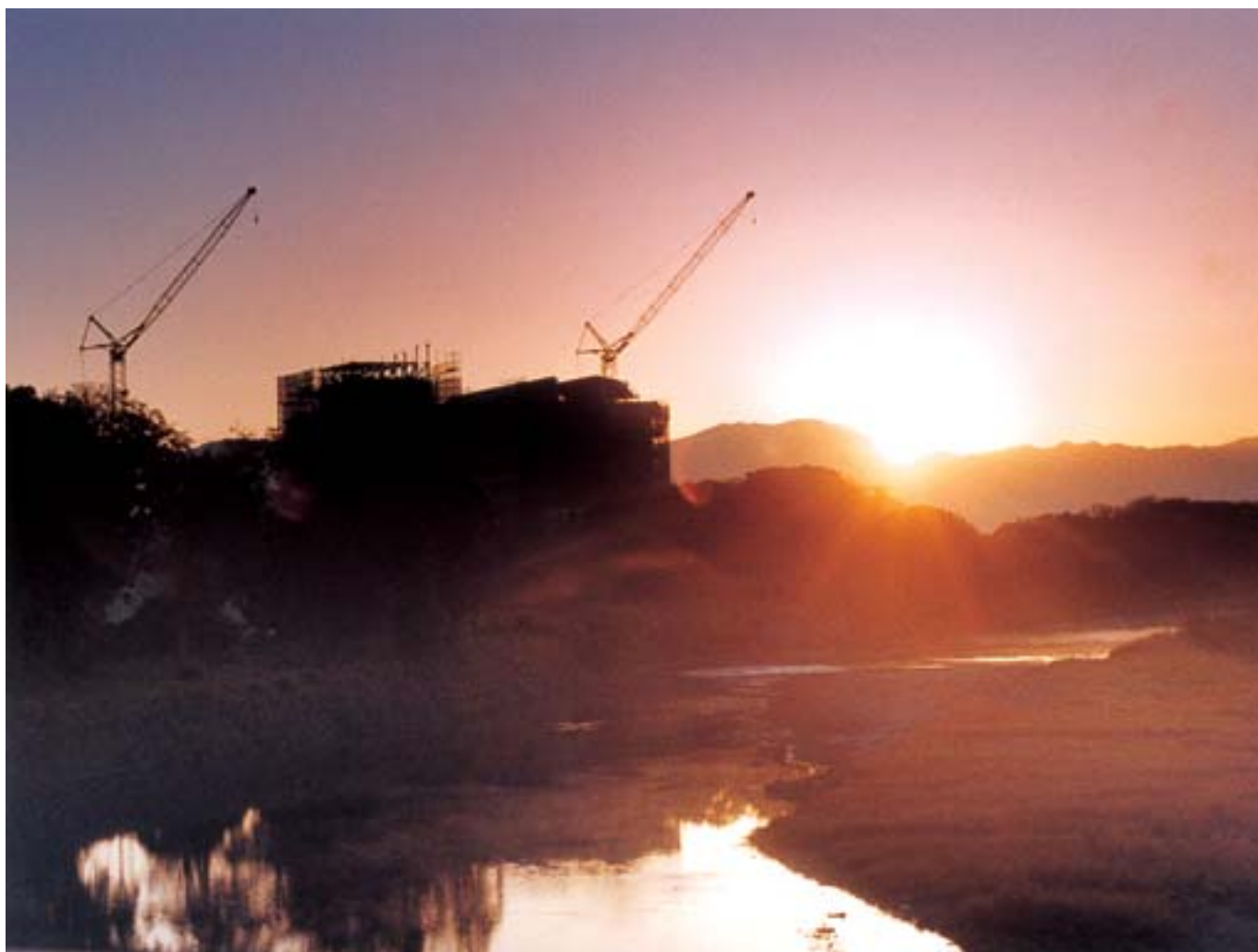
犬上川橋から見る日の出（左手前は建設中の新しい市立病院）
