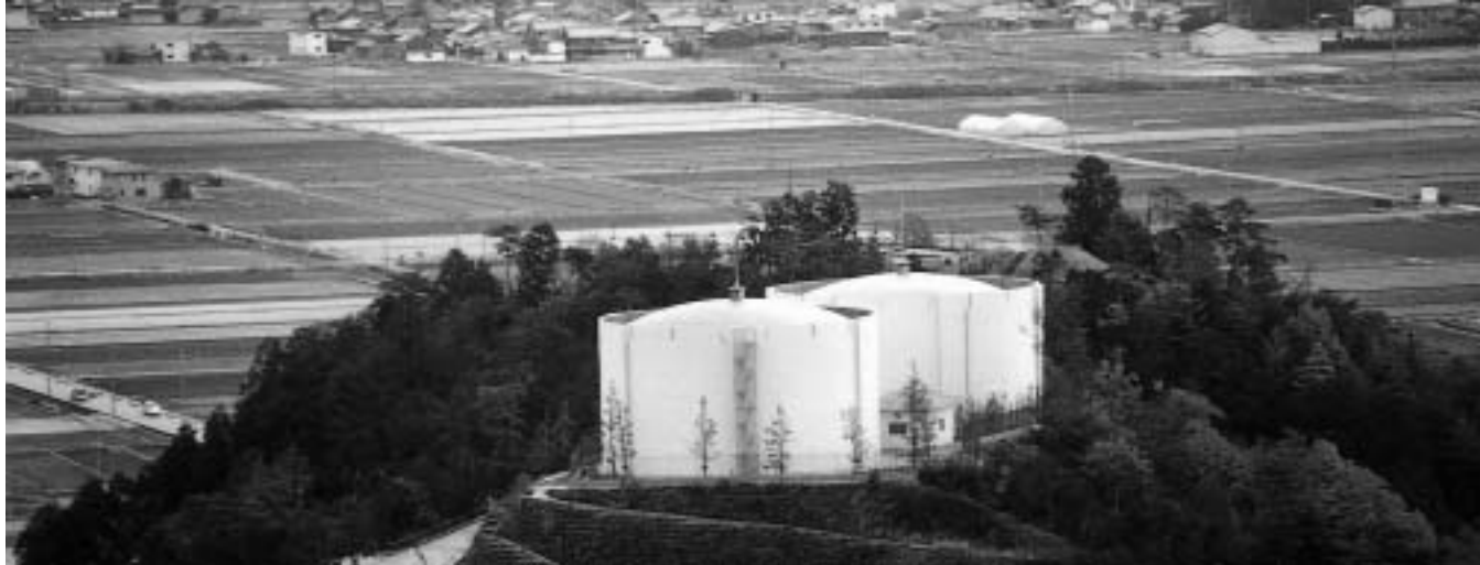
荒神山から見た南部配水池 (手前が新しく完成した2号池)
