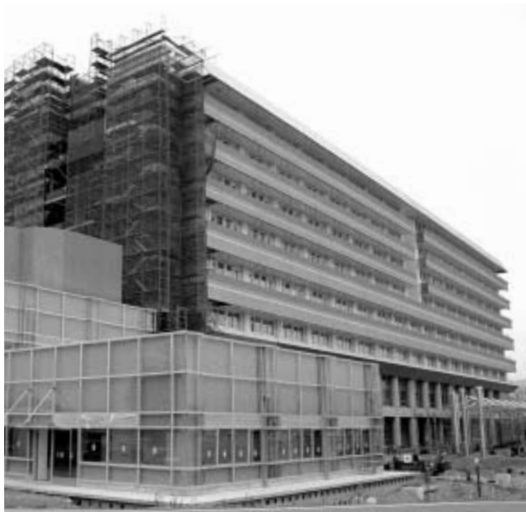
▲ 本体工事をほぼ終えた新市立病院
