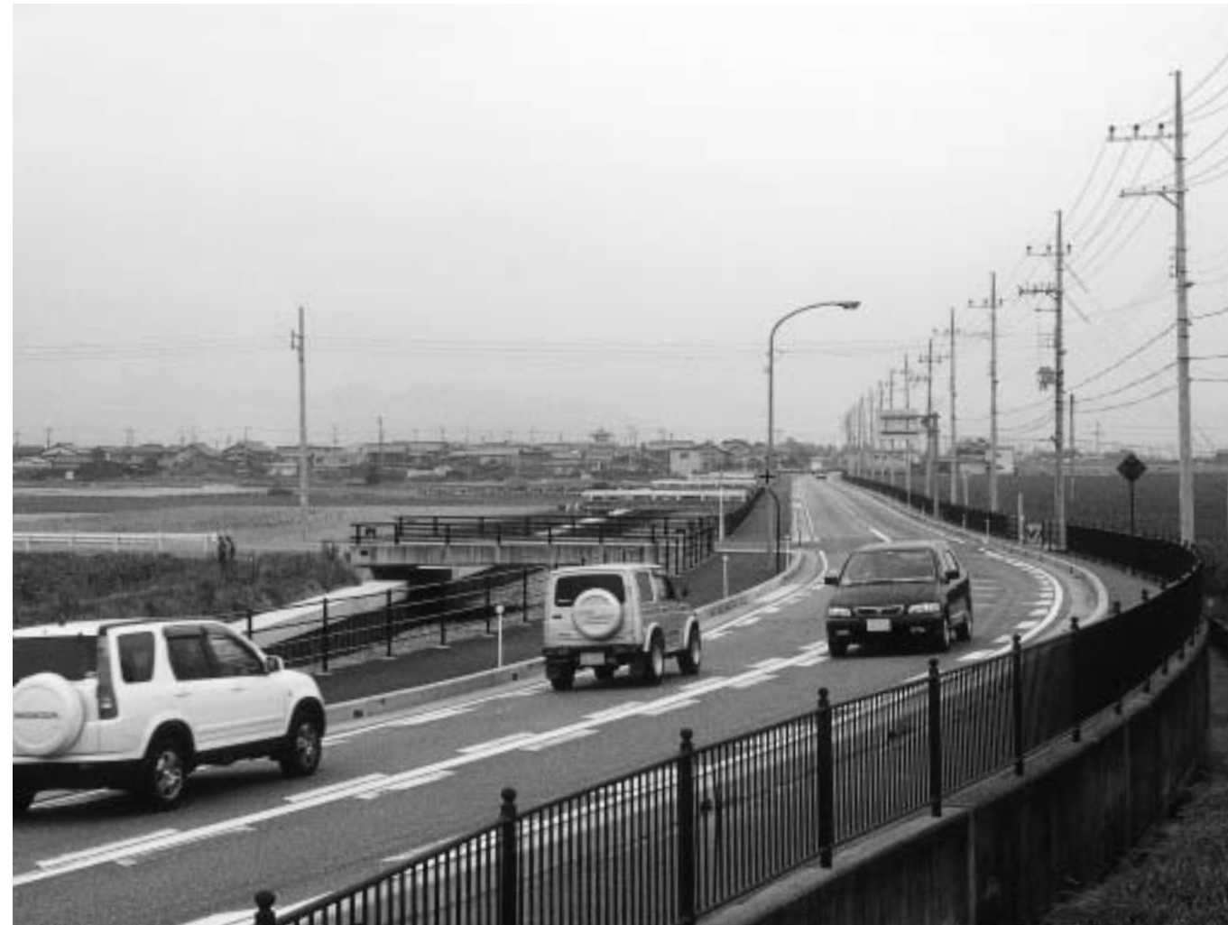
主要地方道愛知川彦根線と拡幅工事が終わった不飲川（普光寺町） のまず
