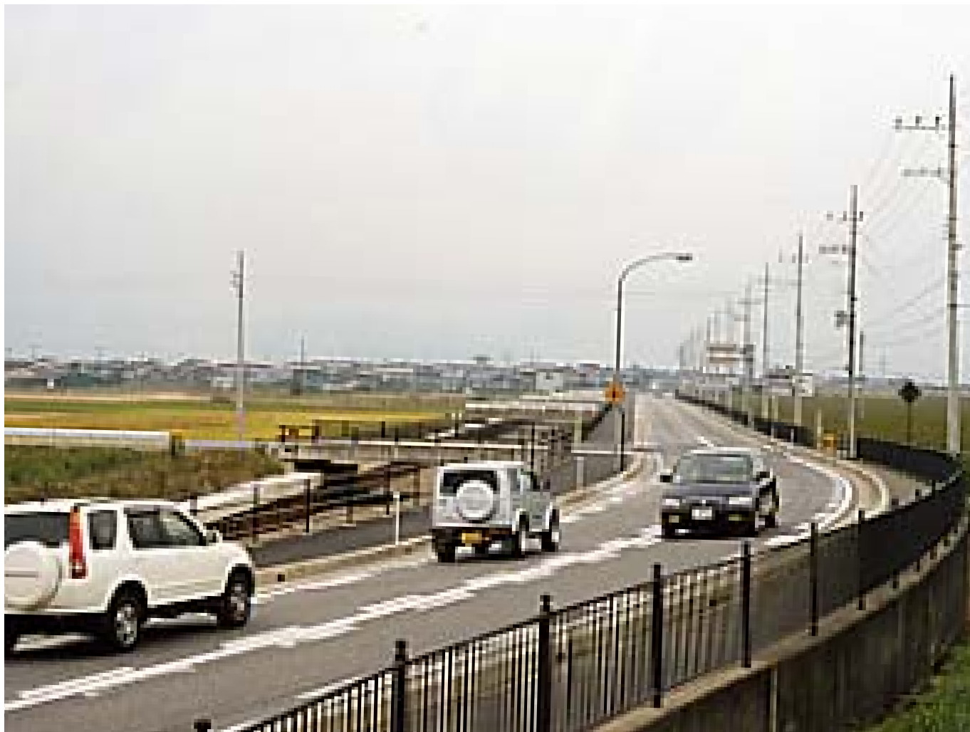
主要地方道愛知川彦根線と拡幅工事が終わった不飲川（普光寺町） のます
