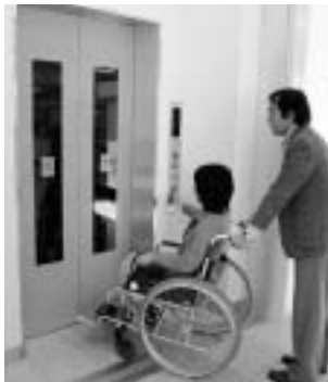
南彦根駅に設置したエレベーター
