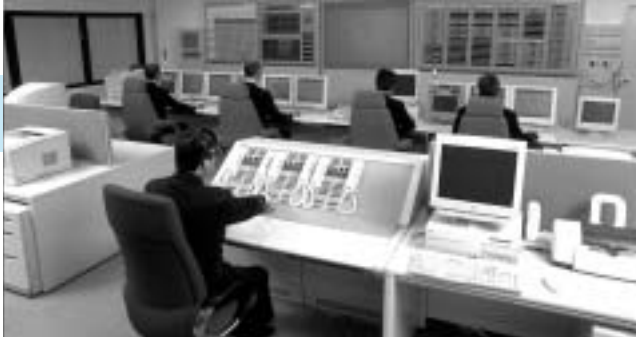
消防緊急通信指令施設
