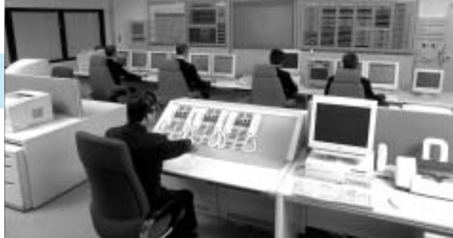
消防緊急通信指令施設
