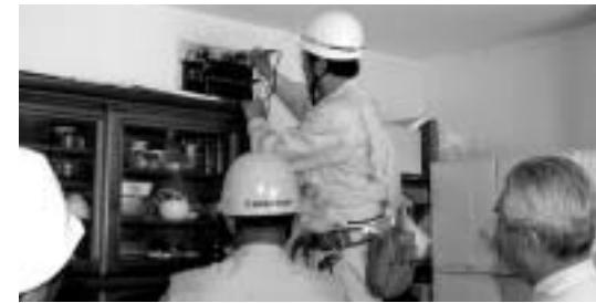
分電盤の漏電を1回路ずつ検査します。
