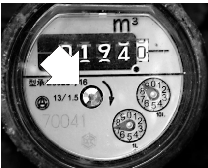
▲水道メーター内のパイロット
