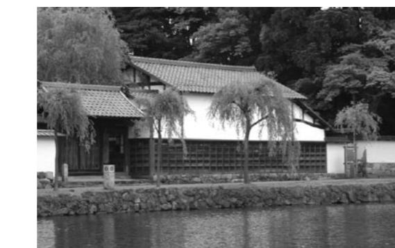
▲中堀沿いに立つ埋木舎
