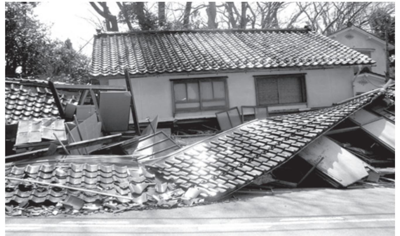
▲平成 19 年に起こった能登半島地震によって、1 階部分が倒壊した住宅（石川県）
