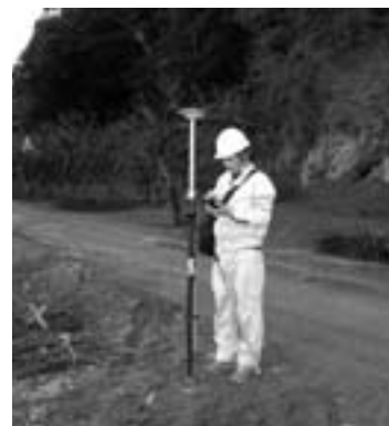
▲GPSを活用した測量風景
