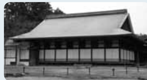
▲整備事業により修理された楽々園建造物(御書院棟)の外観
