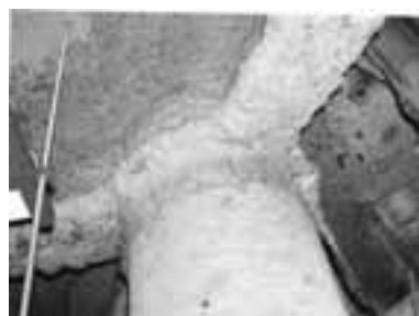
▶出所 国土交通省資料「目で見える アスベスト建材レベル」
