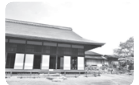
◀玄宮楽々園御書院棟の修復完成
