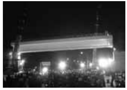
湖東三山スマートICランプ橋の架設工事
