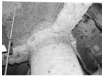
▲出所 国土交通省資料「目で見るアスベスト建材レベル1」
