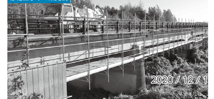
修繕工事中の栗見橋
