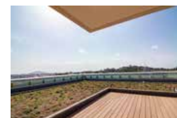
▲テラスと屋上緑化
