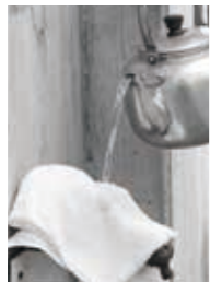
▲水道管の解凍方法
