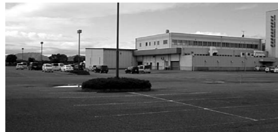
▲給食センター建設予定地（右奥の建物は彦根総合地方卸売市場）
