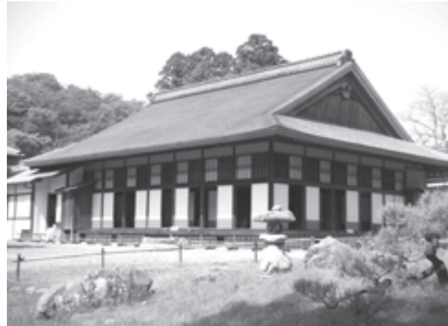
▲楽々園内にある建造物「御書院」の外観
