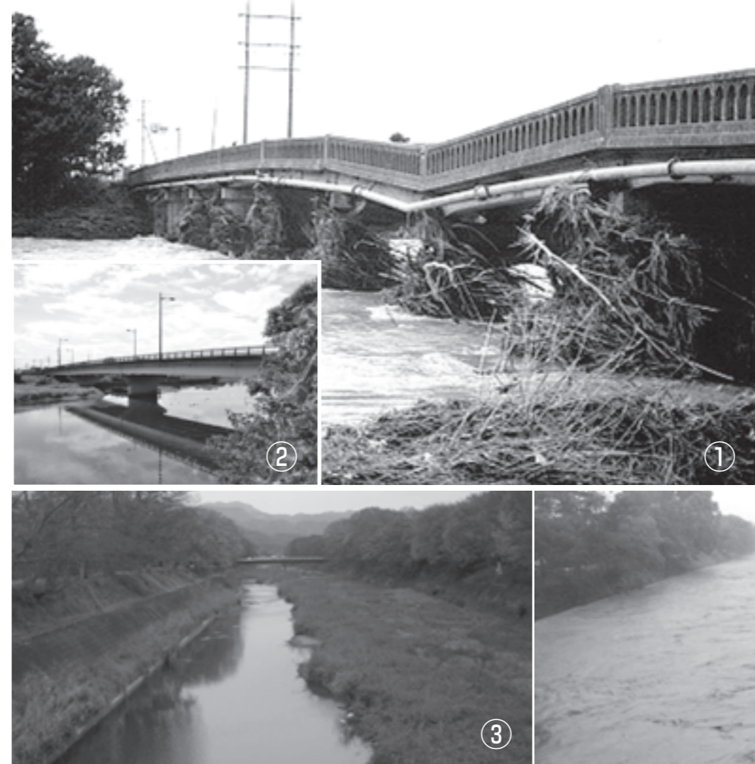
写真①は、平成2年の台風19号で崩れた犬上川橋。この台風では、家屋の浸水被害も発生しました。写真②は現在の犬上川橋の様子。 写真③は、平時の芹川。特別警報が発令された平成25年の台風18号襲来時には、写真④のように増水し全市民の3割強に避難指示が出され、実際に1,700人以上の人が小学校などに避難をしました。(写真③、④は滋賀県提供)
