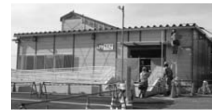
▲駅舎改築中に利用する稲枝駅仮駅舎
