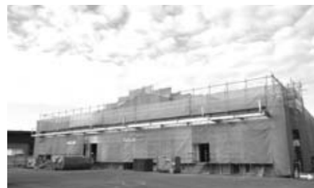
▲彦根総合地方卸売市場(食中町)敷地内に建設中の学校給食センター
