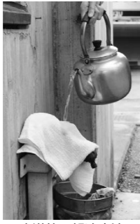
▲水道管の解冻方法
