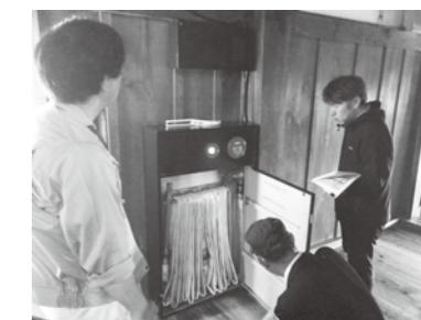
彦根城屋内消火栓の点検
