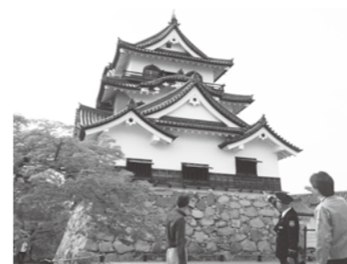
彦根城天守の点検
