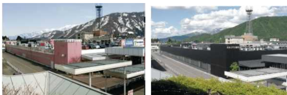
出典：エンジニア・アーキテクト協会 HP 外観写真（左：既存建物、右：改装後）
