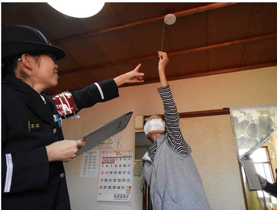
住宅用火災警報器の作動確認（点検）の様子
